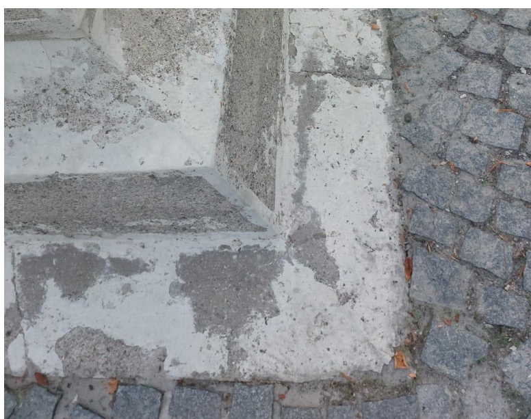
Slika 9 (lijevo): Podnožje sa zatečenim neadekvatnim rekonstrukcijama bridova i manjih oštećenja nakon čišćenja površine; vidljive pukotine u podnožju baze; detalj
