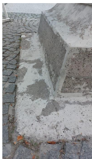
Slika 9 (lijevo): Podnožje sa zatečenim neadekvatnim rekonstrukcijama bridova i manjih oštećenja nakon čišćenja površine; vidljive pukotine u podnožju baze; detalj
