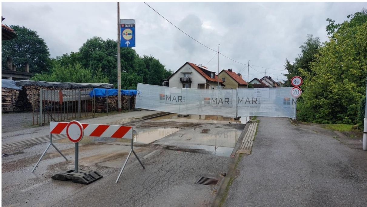
Radi se o prvom armiranobetonskom mostu u Hrvatskoj, izgrađenom 1900. godine. Most je propao zbog više desetljeća neodržavanja, što je posljedično dovelo do lošeg stanja konstrukcije s oštećenim i odlomljenim zaštitnim slojevima betona, s armaturom vidljivo oštećenom od hrđe, na mjestima potpuno „pojedenom“, pa je Grad Ogulin je 2021. potporama pojačao most te je odmah pokrenuo postupak izrade dokumentacije za njegov popravak ili rušenje.
