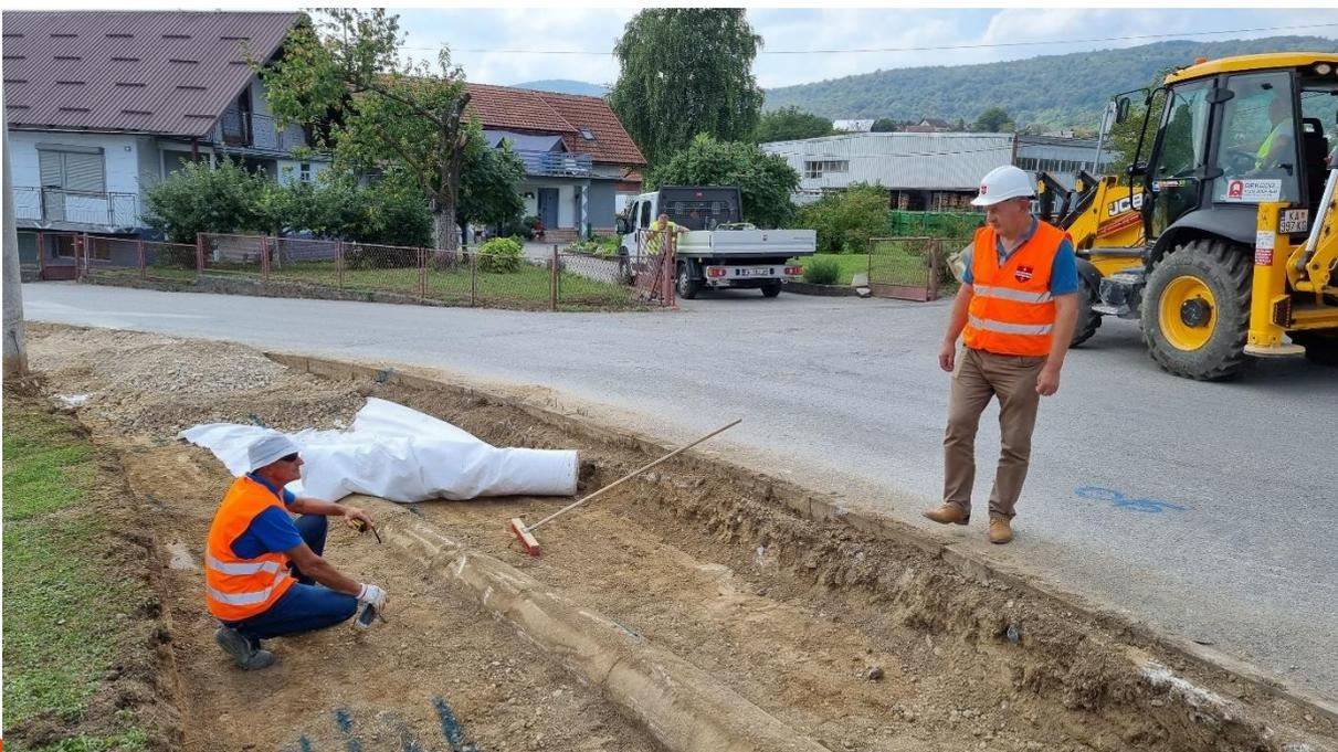
U sklopu proširenja se izvode potporni zidovi, nova rasvjeta, odvodnja prometnice te vertikalna i horizontalna signalizacija, a izvodit će se i novo autobusno stajalište. Sukladno sporazumu s Županijskom upravom za ceste Karlovac Grad Ogulin provodi radove proširenja prometnice, dok će ŽUC Karlovac provoditi radove uređenja kolničke konstrukcije.
