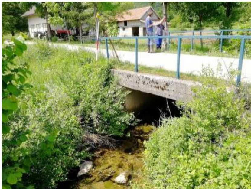
Slika 2-7. Betonski propust na stacionaži 1+440.00 (izvor: Idejni projekt, Vodoprivreda Karlovac d.d., 2018.)
