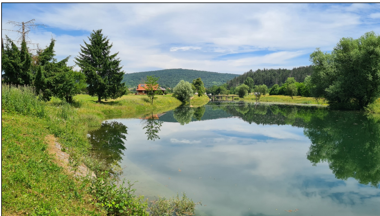
Slika 10. Pogled uzvodno na desnu obalu Gornje Dobre s lokacije završetka postojeće obaloutvrde i početka neutvrđene obale (predmetni zahvat)
