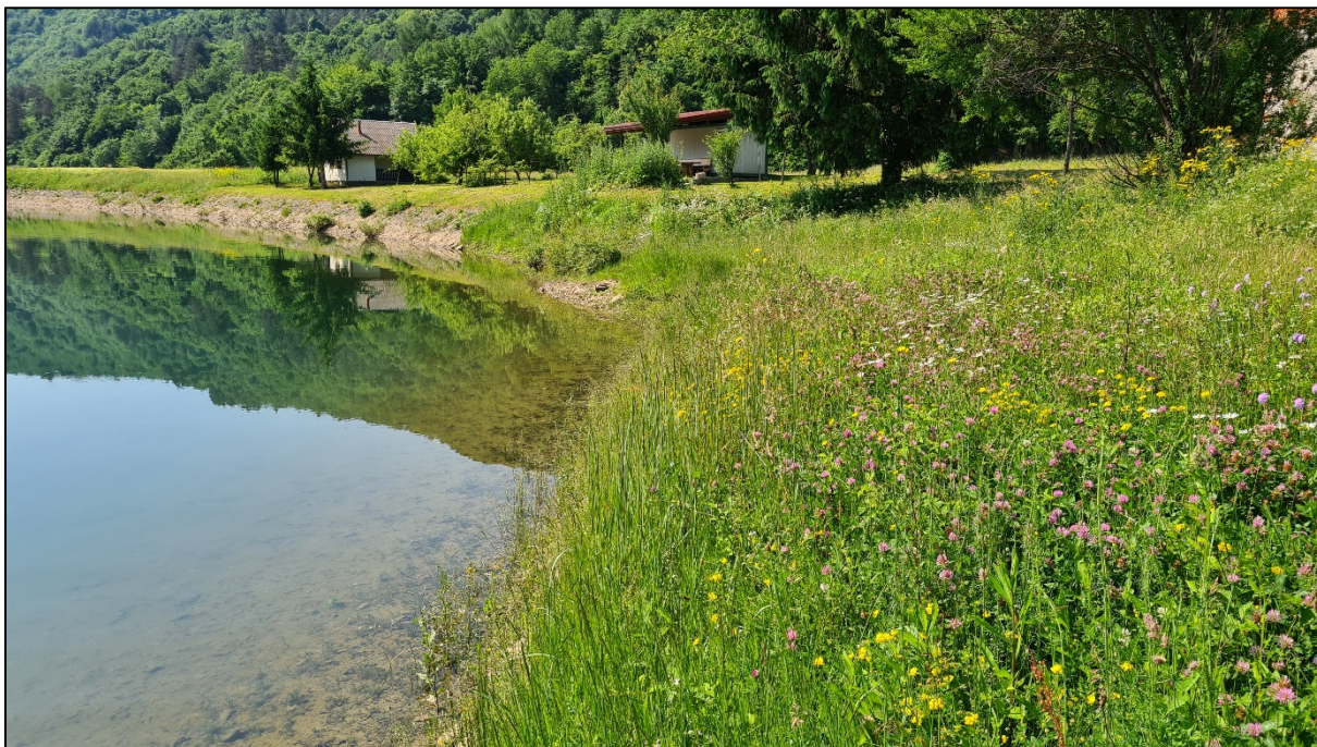
Slika 9. Pogled nizvodno na desnu obalu Gornje Dobre, vidi se završetak postojeće obaloutvrde i početak neutvrđene obale (predmetni zahvat)
